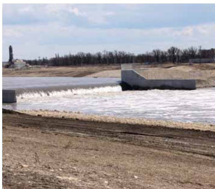
Ouvrage régulateur de sortie du canal de dérivation, au nord de Winnipeg
