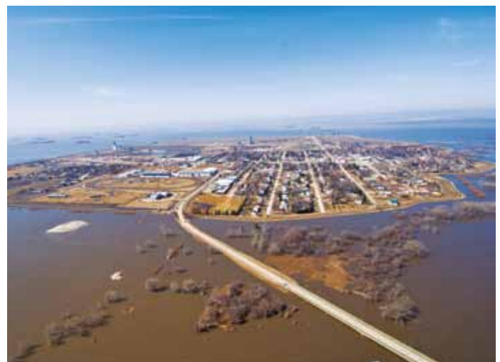
Digue circulaire protégeant la collectivité de Morris
