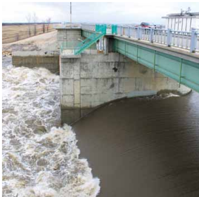
Ouvrage régulateur d'entrée du canal de dérivation, au sud de Winnipeg
