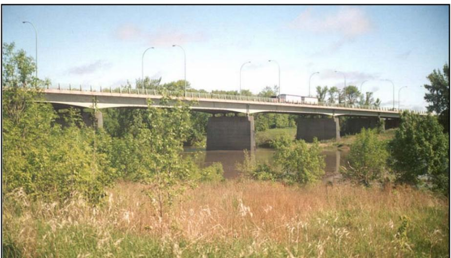
**6.3.7 Ci-dessus : Pont moderne à tablier plat, poutres d'acier et piliers de béton, sur la rivière Rouge à Morris.** (Photo : Direction des ressources historiques.)
