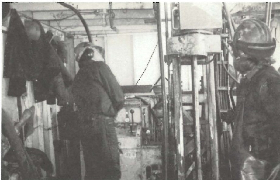
Installation de forage à Namew Lake
