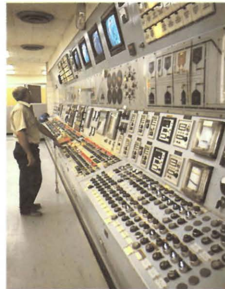
Salle de commande de l'usine d'Inland Cement, à Fort Whyte, 1987.
