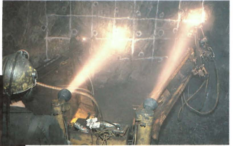
Forage du front de taille pour la mise en place des explosifs à la mine Ruttan de Sherritt, 1986.
