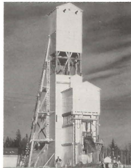
Premier puits de mise en valeur de la mine Thompson d'Inco (T-2), 1956.
