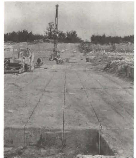
Coupe de la pierre de Tyndall, près de Garson. Les lignes droites ont été faites au moyen d'une scie circulaire à dents en carbure de tungstène.
