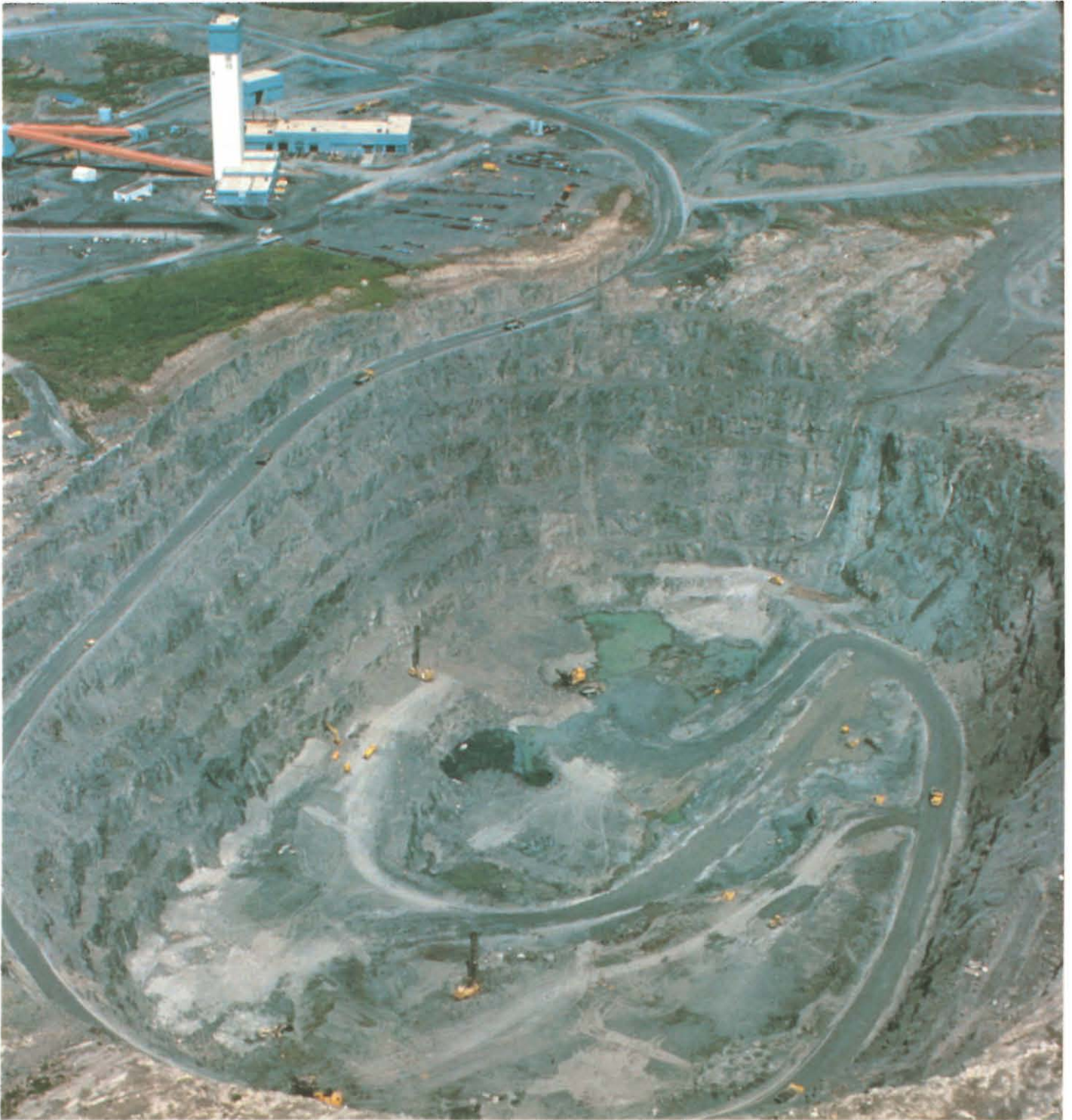
Mine à ciel ouvert Pipe d'Inco Limited, et chevalement n° 2 à l'arrière-plan. Les grosses pelles mécaniques, les foreuses et les camions semblent minuscules par rapport aux dimensions de l'exploitation. Une route d'accès descend le long des parois de la mine (vers 1980).
