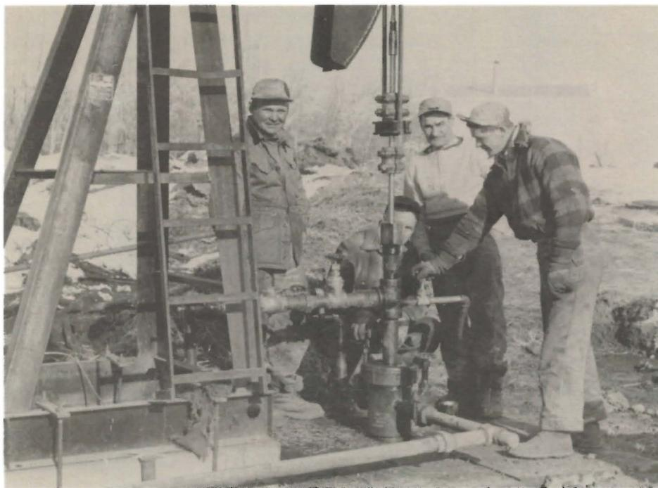
On a extrait en huit mois un total de 135 mètres cubes de pétrole de ce puits, creusé sur la formation mississippienne de Lodgepole (entre 671 mètres et 712 mètres de profondeur) (voir figure 1). Il s'agissait du premier puits pétrolier commercialement rentable découvert dans le riche bassin nord-américain de Williston. À l'heure actuelle, le Manitoba, la Saskatchewan, le Dakota du Nord, le Dakota du Sud et le Montana profitent tous des richesses de ce bassin.
