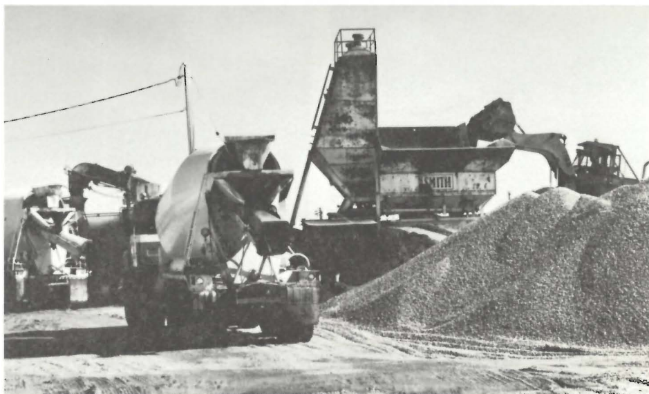
Figure 9 Les tas de graviers sont mélangés pour être transformés en béton par une usine mobile; le béton est ensuite transporté par camion vers le chantier.
