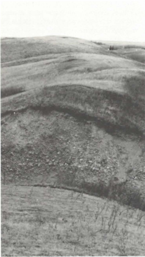
Figure 5 Route en déblai traversant la crête d'un eskar au nord de Oak Lake. L'eskar est composé de sable et gravier à haute teneur d'argile.
