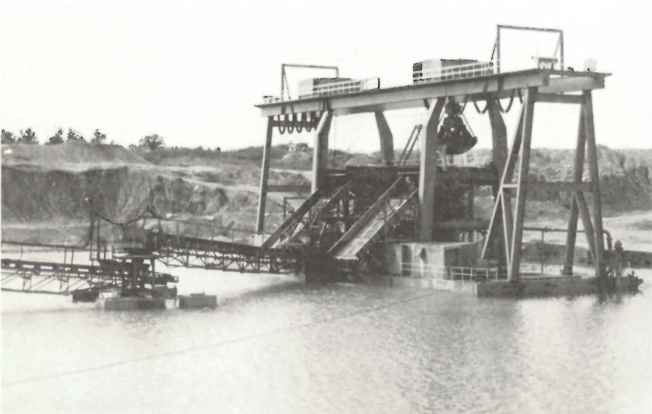
Figure 18 Excavatrice à bennes preneuses jumelées flottante en opération à la carrière de Birds Hill. Le sable est extrait jusqu'à une profondeur de 20 mètres et transporté sur la berge par un convoyeur flottant pour y être traité.
