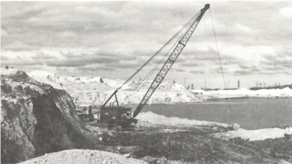
Figure 17 Extraction à la pelle-benne traînante sous la couche phréatique dans une carrière de Birds Hill.
