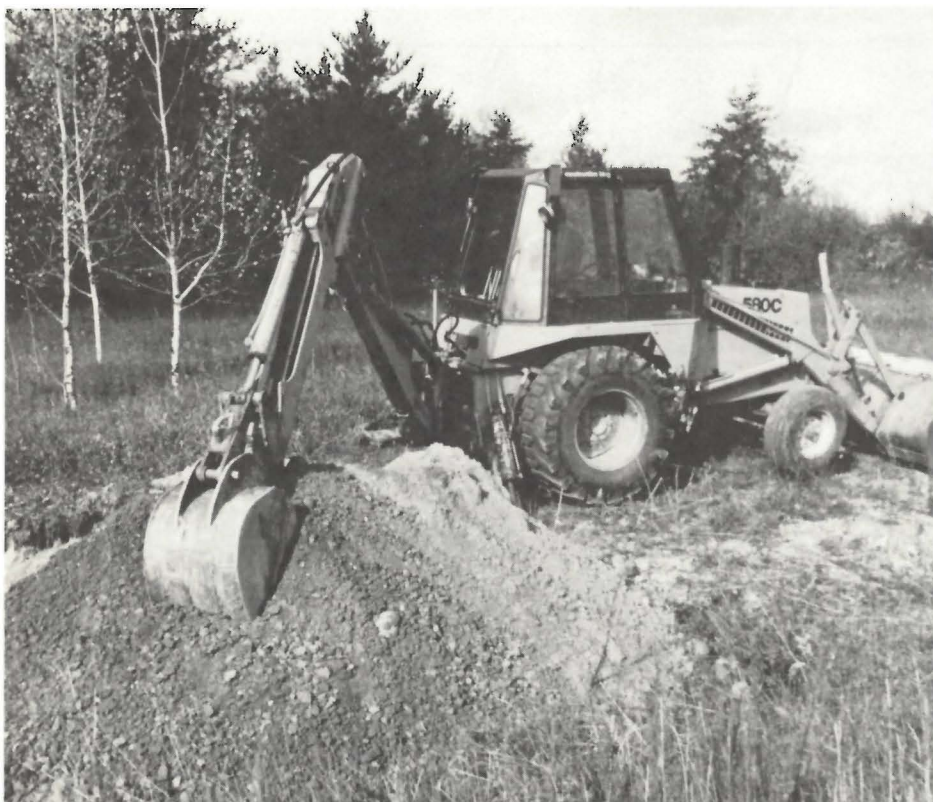
Figure 14 Test dans un site potentiel avec une pelle mécanique.
