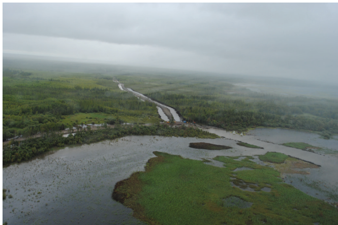
Barge and Drainage Channels – Mid August / Canaux de drainage et pour barges – mi-août
