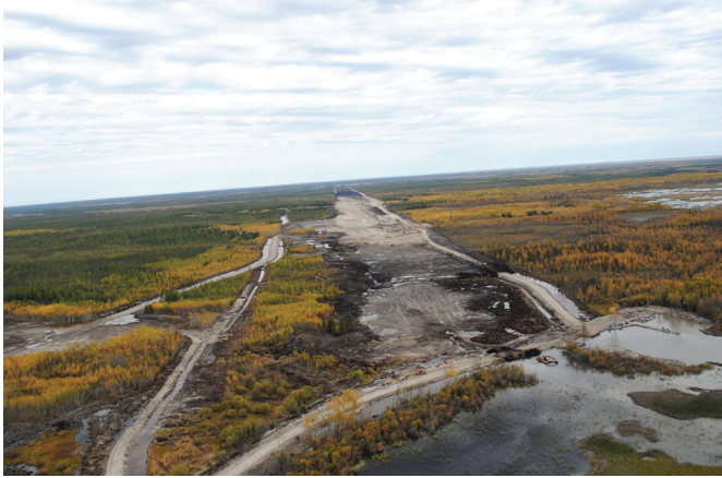
Channel Progress by October 2 / Progrès entourant le canal - 2 octobre
