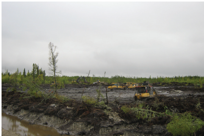
Clearing Peat and Trees / Nettoyage de la tourbe et des arbres
