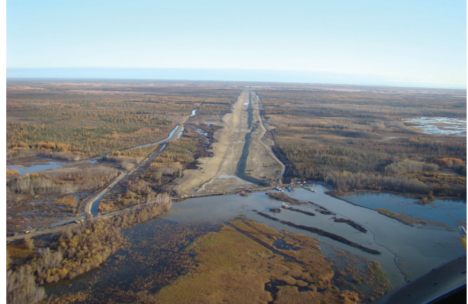
Channel nearing Completion - October 25 / Canal peu avant l'achèvement - 25 octobre
